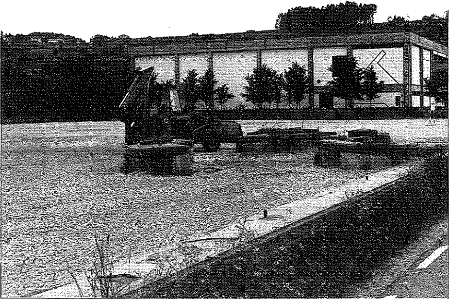
Julio 1986. Construcción de un aparcamiento
