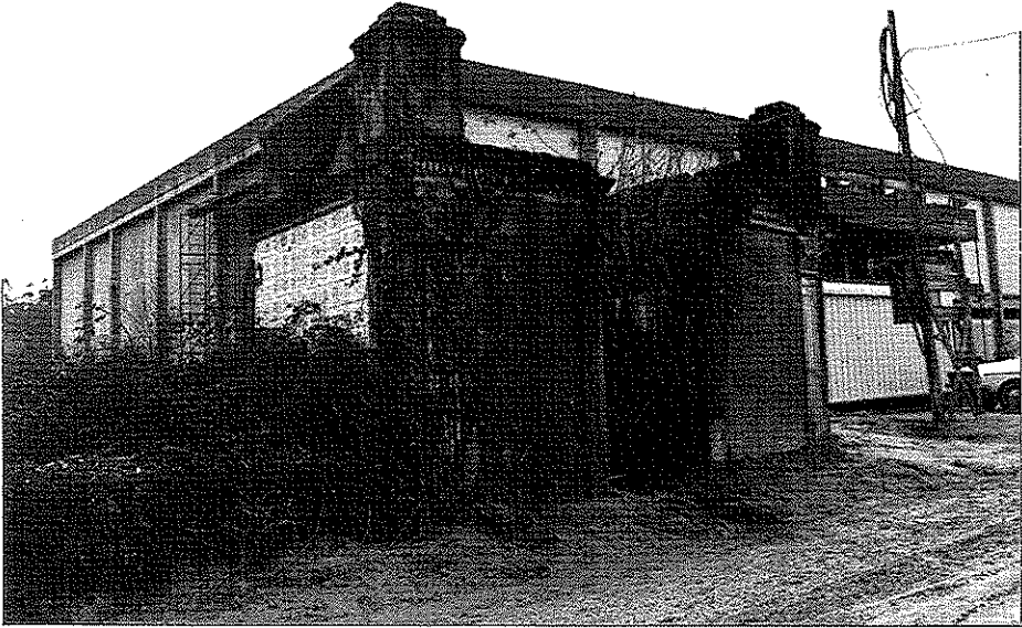
1985. Derribo del último resto de la «Sala de los Espejos»
